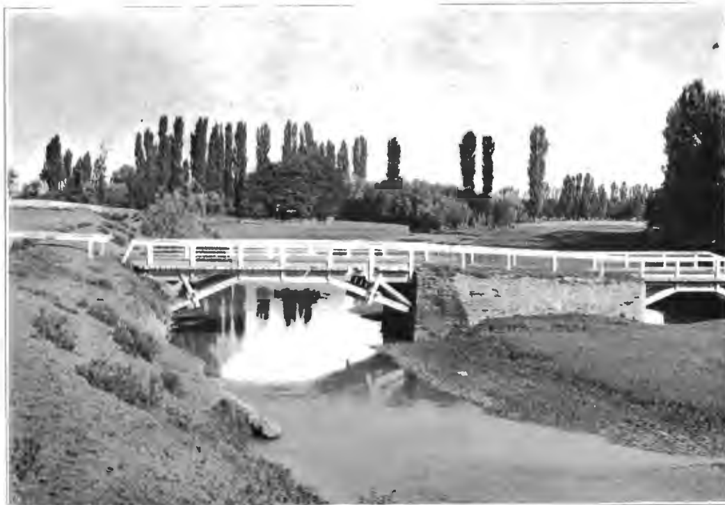
Мостъ черезъ р. Алму въ дер. Бурлюкъ. Перестроенъ заново послѣ 1855 года.
